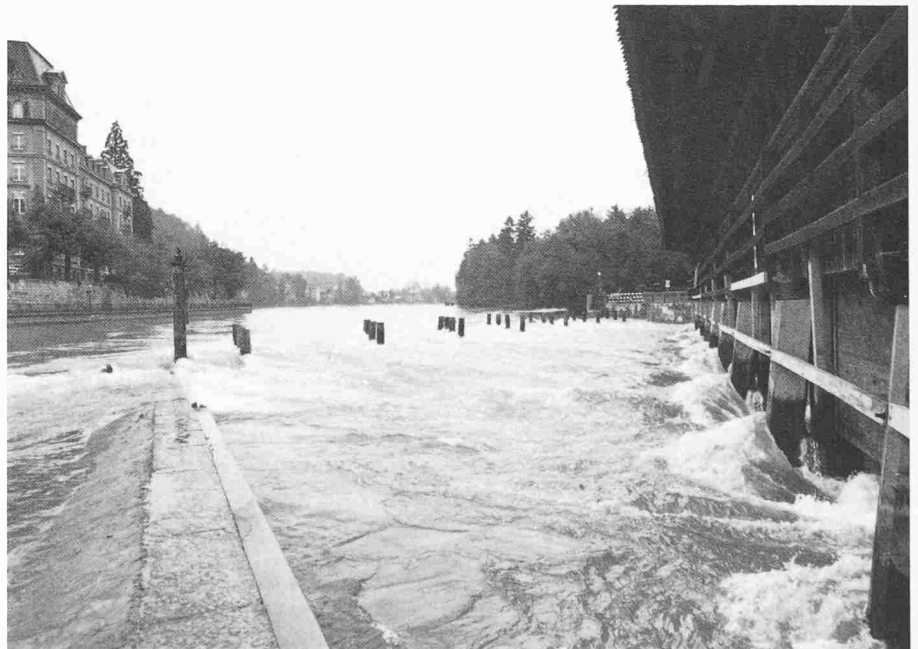
Blick flussaufwärts vom Bälliz-Zinggen. Die Pfähle der Hilfsbrücke konnten erst später entfernt werden
