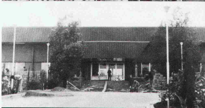
Empfangshalle Khamis Mushayt, Empfangshalle Tabuk, Saudi-Arabien
