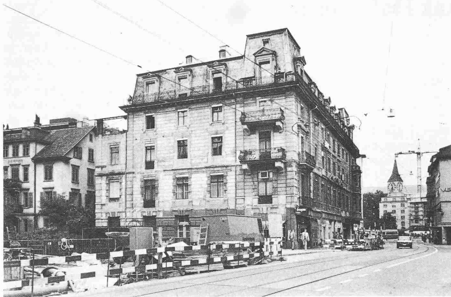
Der Bau vor der Renovation: Blick von Südwesten
