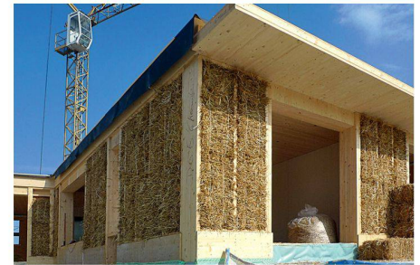
02 Holzständerbau mit eingebrachten Strohballen
