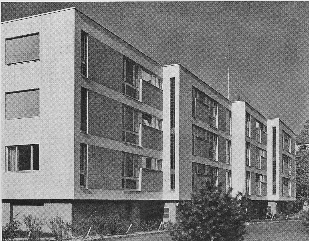
Rückfront des gestaffelten Gebäudes aus Nordosten
