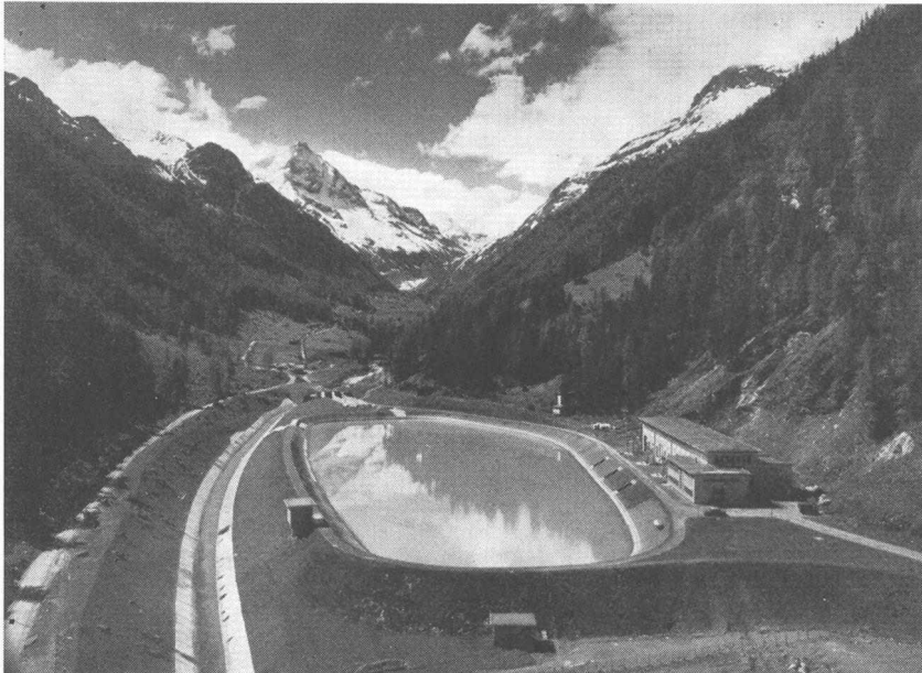
Ausgleichsbecken Motec der Kraftwerke Gougra AG
