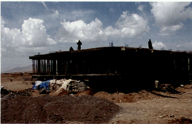
Häuserbau in der Provinz Loghar.
