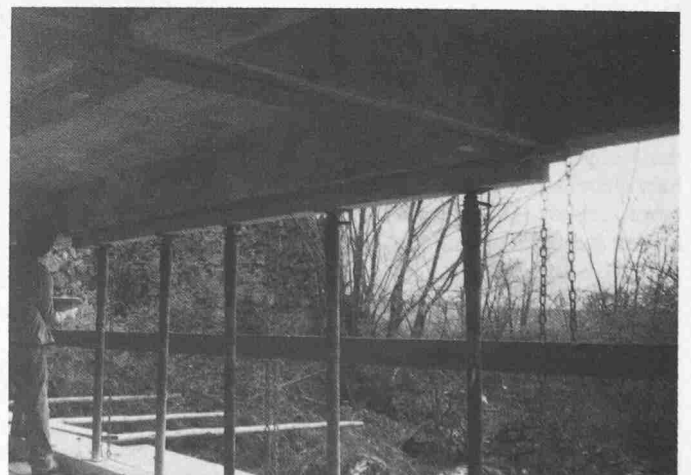
Bild 7. Anpressen der Bleche an den Konstruktionsbeton. Mit den Deckenspriessen und dem Kantholz wird ein gleichmässiger Anpressdruck erreicht. Die Spriessen stützen sich auf dem Gerüst ab, das mit Ketten an der Brücke befestigt ist
