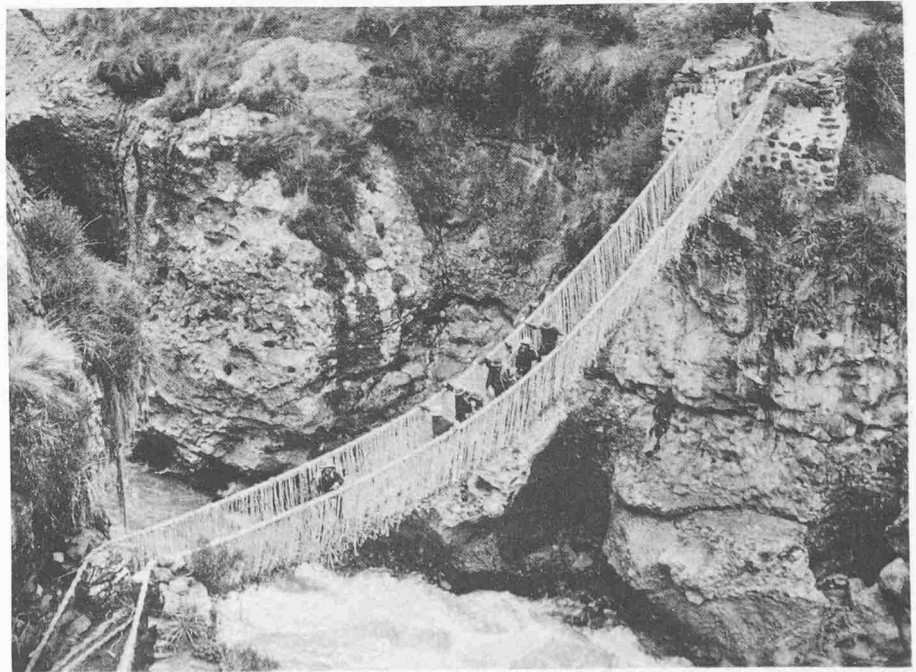
Bei stärkerem Wind schwankt die Konstruktion beträchtlich. Beim Überschreiten hat man aber ein Gefühl der Sicherheit, und die Tragfähigkeit ist erheblich
