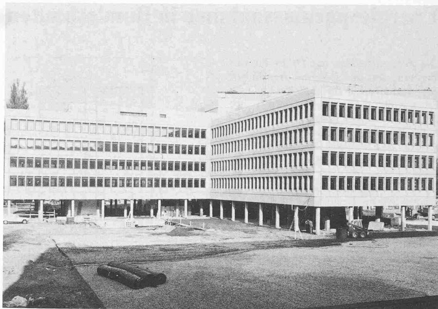
Bild 3. Fassade des Verwaltungszentrums Bern – Beundenfeld Dank Reduktion der Fensterflächen, optimaler Wärmedämmung der Fassaden und Fenster usw. kann der Wärmehaushalt so verbessert werden, dass das Gebäude während 10 Monaten im Jahr mit der Abwärme des Rechenzentrums, das im Gebäude untergebracht ist, beheizt werden kann. Nur während den zwei kältesten Monaten des Jahres soll mit Heizöl nachgeholfen werden. Die erwartete Heizöleinsparung liegt in der Grössenordnung von etwa 110 t/Jahr
