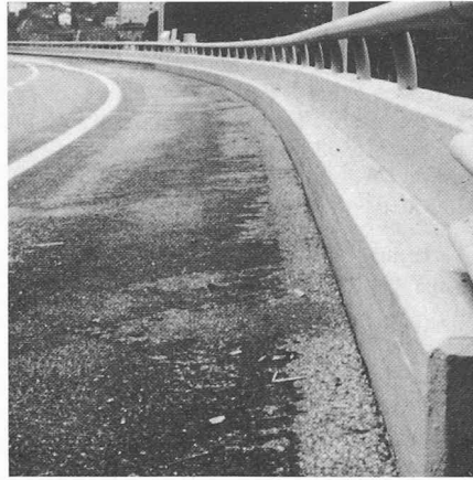
Bild 3b. Schutzanstrich auf Beton
