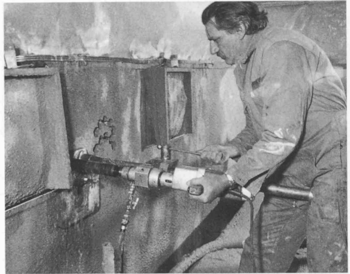
Bild 5. Entnahme von Spritzbetonbohrkernen (Foto: H. Germond, Lausanne)
