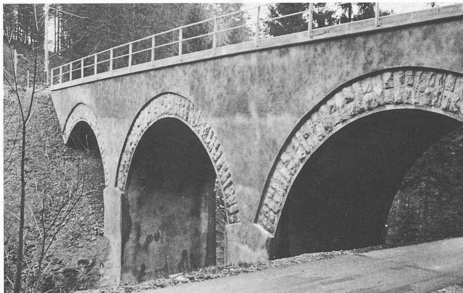
Bild 9. Durch eine verunreinigte Spritzdüse verursachte Fleckung («Leopardenfell»)
