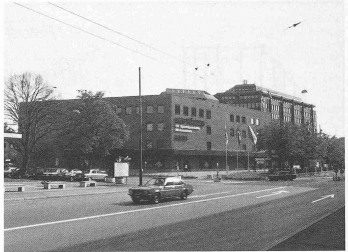
Bild 7. Flachbau von Westen, Ecke Zürcher-/Schützenstrasse
