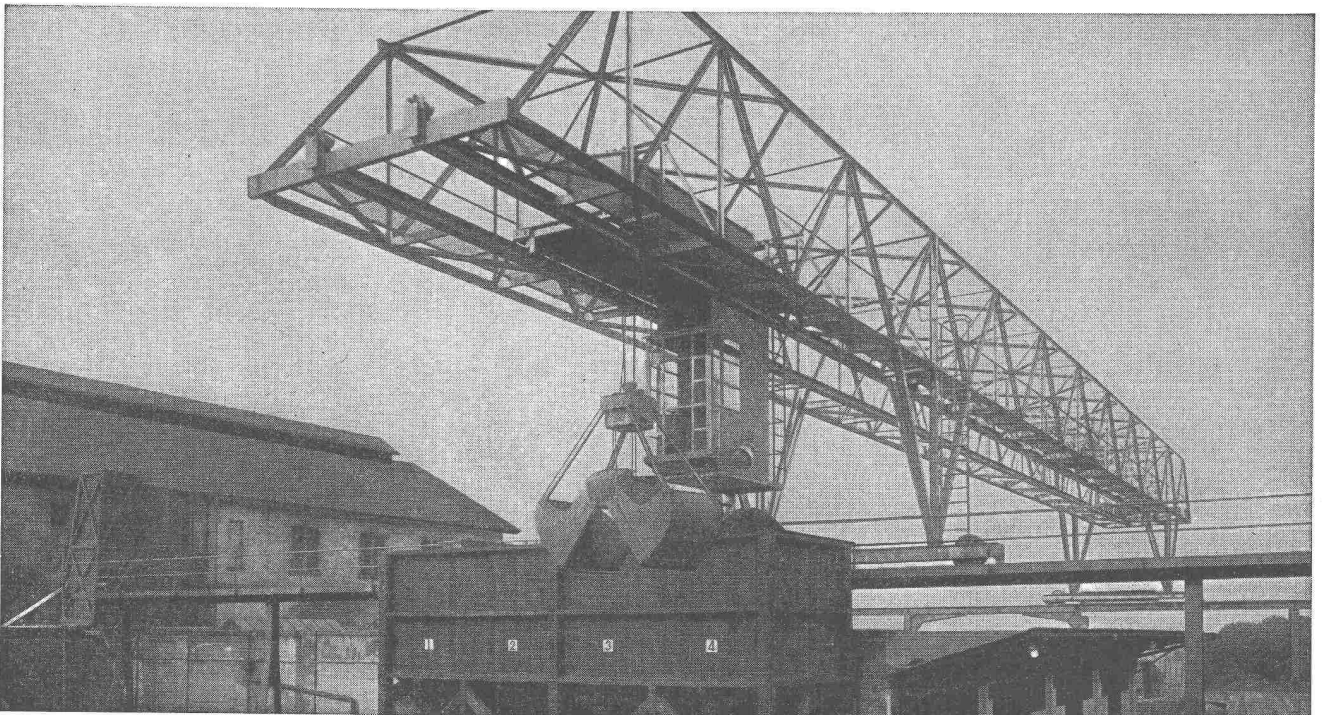
Verladebrücke in Schweisskonstruktion 2,5 t Tragkraft, 46 m Länge
