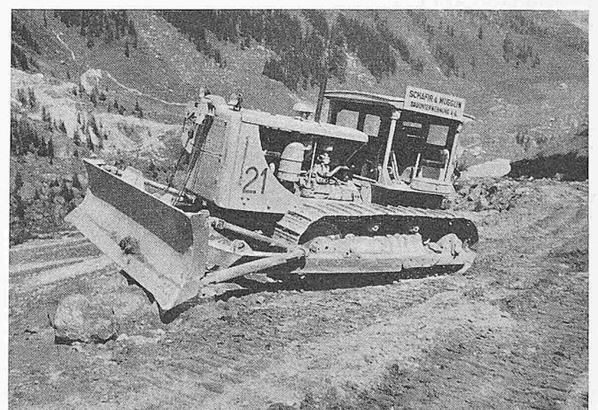
Bild 2. Bulldozer Caterpillar D 8, Gewicht 22 t, Motorenleistung 190 PS
