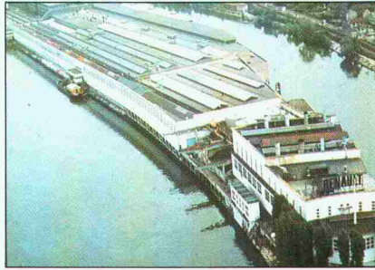
▲ Frankreich : Renault, Boulogne-Billancourt. (Sanierung)
