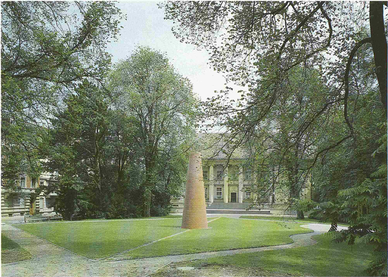
Die Wege als Konturen des unterirdischen Baues – der Kamin als Bauteil des Museumdepots, hinten das Historische Museum
