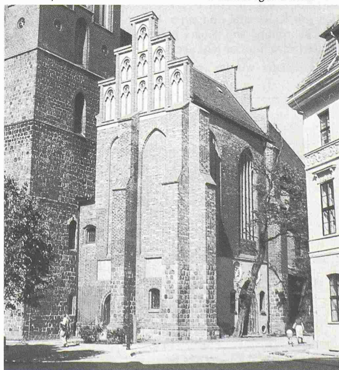
Kapellenanbauten des 15. Jahrhunderts mit Stufengiebeln: Liebfrauenkapelle nach dem Vorbild des Brandenburger Domes
