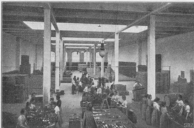
Fig. 8. Vue intérieure de l'un des trois ateliers.
