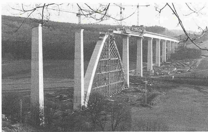
Bild 2. Mülmisch-Talbrücke; der Bogen (A-Bock) ist eingerüstet und betoniert
