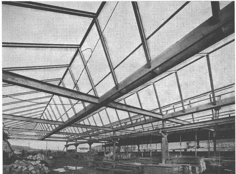
Shedbau, vollständig geschweisst
