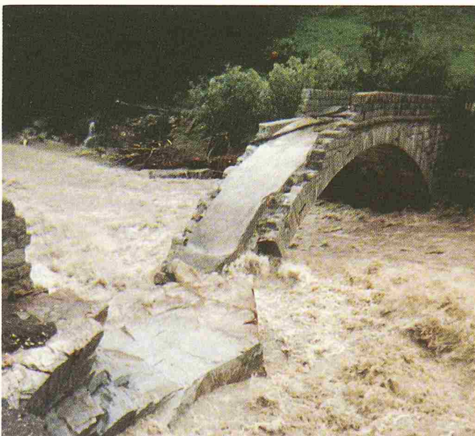
Bild 3. Schluchtenbrüggli oberhalb der Reussbrücke Wassen Bildautor: R. Kalbermatten
