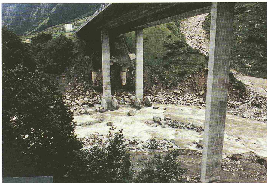
Bild 13. Rechtes Ufer beim Widerlager Nord, und Pfeiler B/G Bildautor: T.R. Schneider, 1878/25
