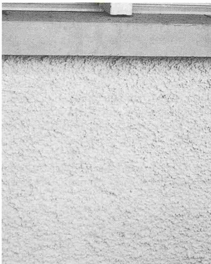
Bild 16. Kellenwurf als Deckputz. (Lindenplatz, Pfungen)
