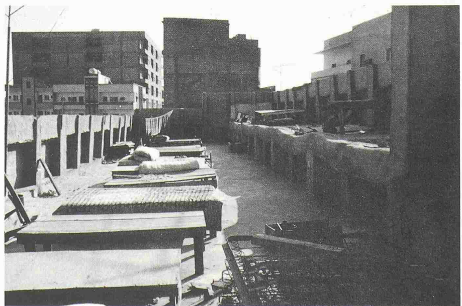
Teilweise Benützung des Flachdaches zum Schlafen
