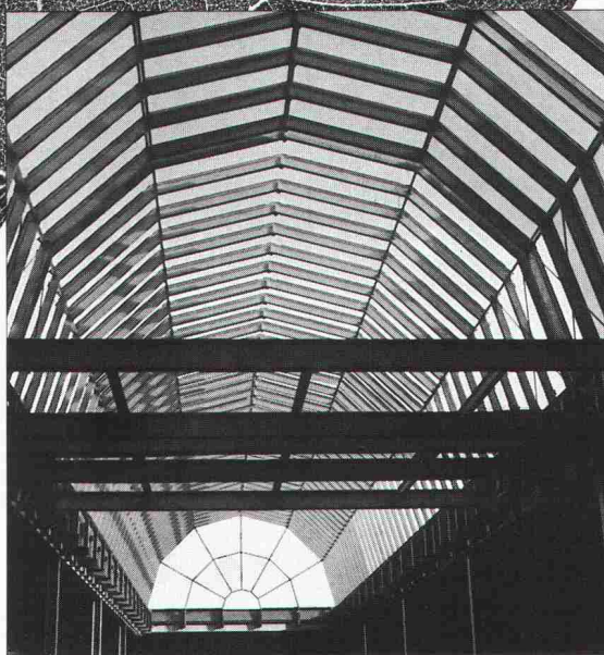
Stahl- und Industriebau
