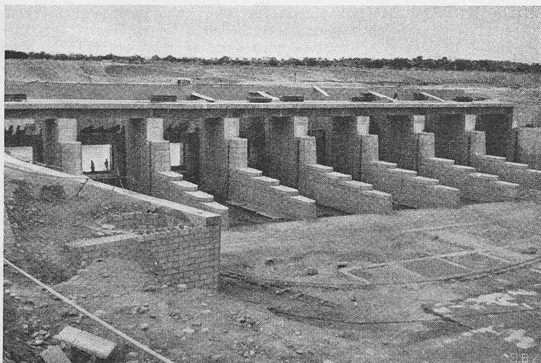
Bild 7. Einlaufbauwerk für den Umleitungskanal am Nangal-Stauwehr
