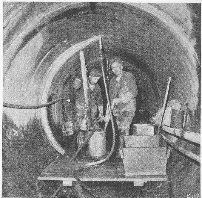
Bild 16. Druckschacht; Zementinjektionen
