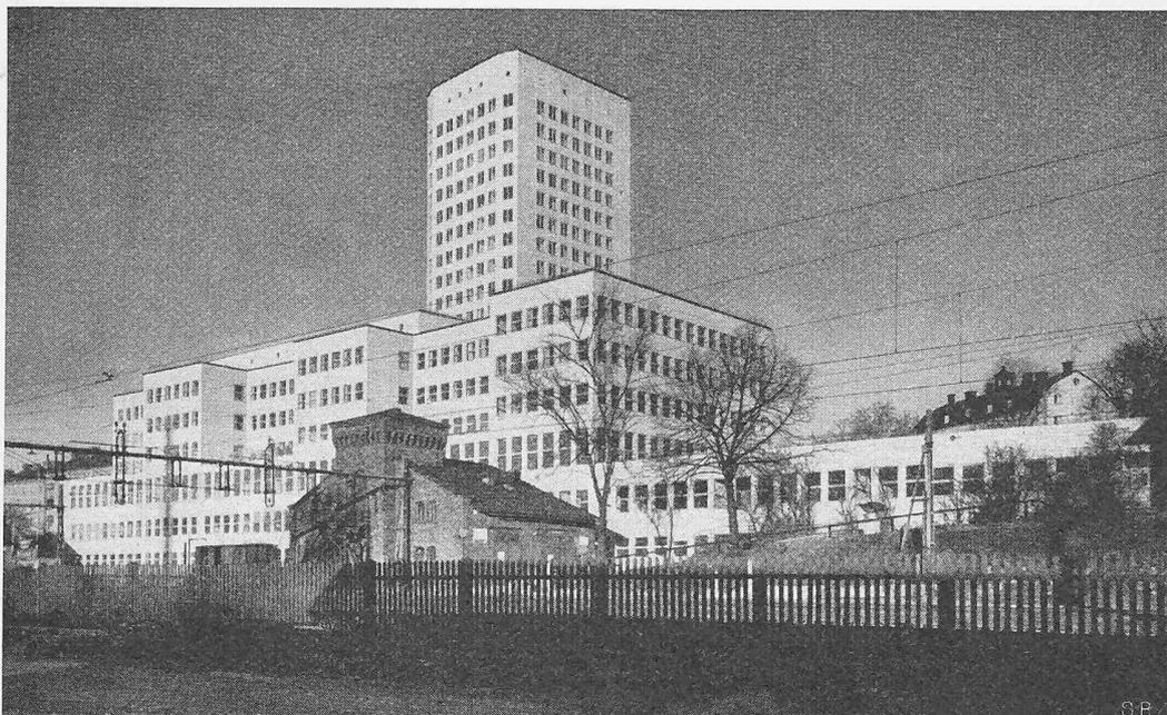
Bild 17. Hochhaus einer grossen Verlagsfirma in Stockholm. Wände aus tragendem Beton, isoliert mit 5000 m<sup>2</sup> Siporexplatten von 0,4 kg/dm<sup>3</sup> Raumgewicht. Fassadenverkleidung mit hellen Ziegelstäben in Mörtel verlegt.
