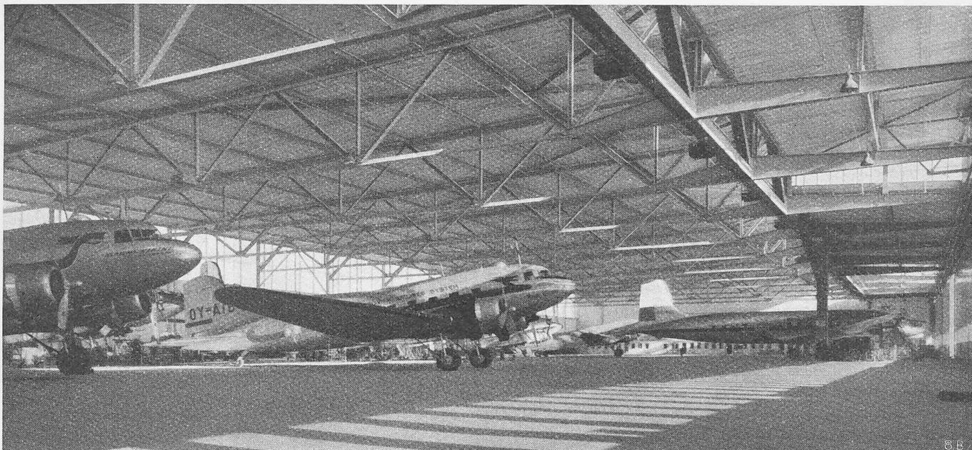
Bild 15. Die Flugzeughalle (geschweisste Stahlkonstruktion) auf dem Flughafen Bromma ist mit 9000 m<sup>2</sup> armierten Siporex-Dachplatten von 0,5 kg/dm<sup>3</sup> Raumgewicht gedeckt und mit 3000 m<sup>2</sup> Siporex-Platten von  $\gamma = 0,4$  kg/dm<sup>3</sup> isoliert
