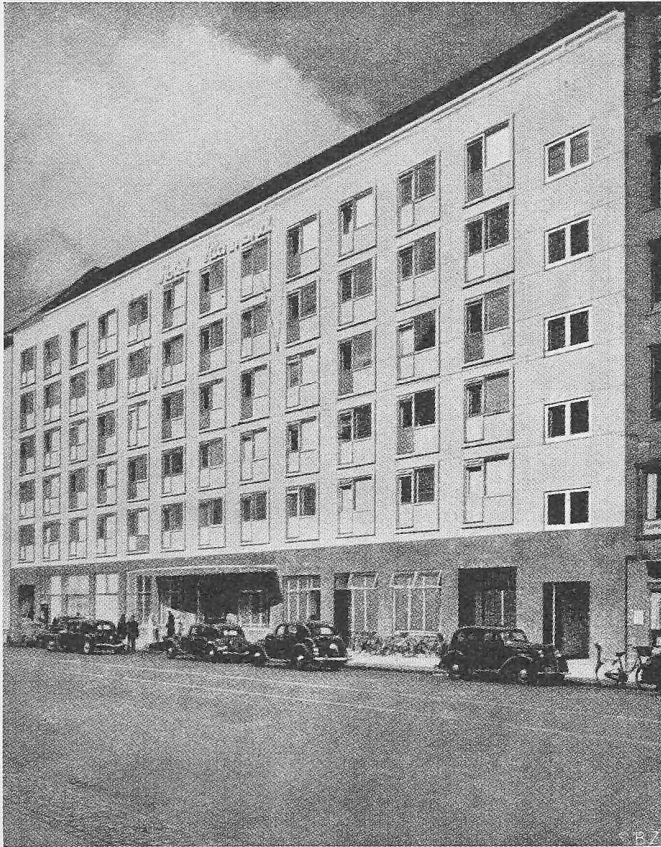
Bild 9. Hotel Richmond, Hauptfassade
