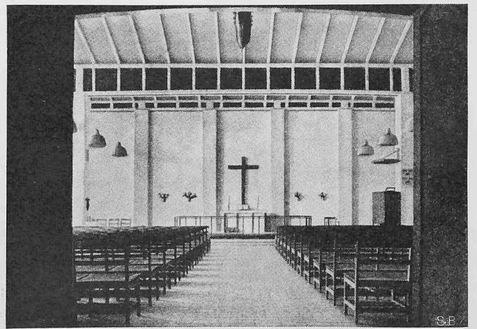
Bild 22. Blick durch den Kirchenraum gegen den Altar. Sichtbare Sparren und Holzbinder.
