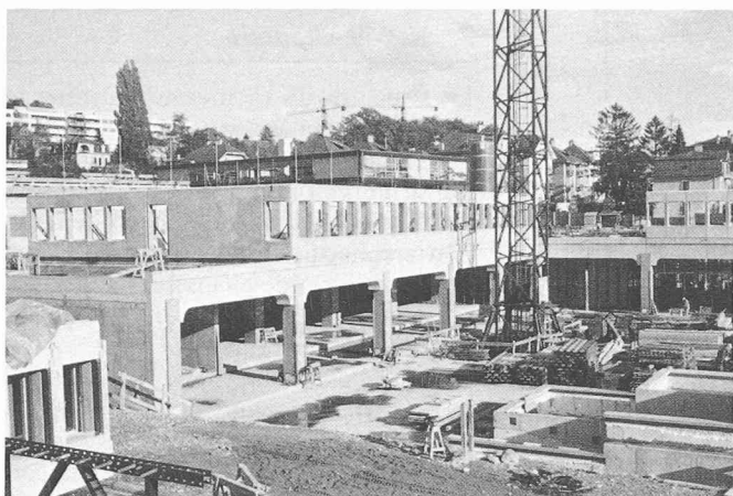
Fig. 8. et 9. — Pose des façades en éléments préfabriqués.
