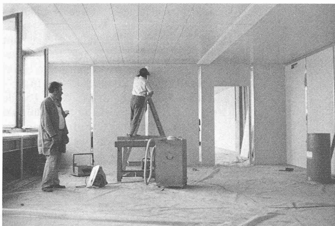
Fig. 10. — Montage des cloisons mobiles.
