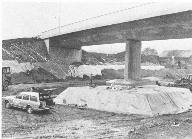
Fig. 3. — Seule la fondation d'un pont traversant la N1 perfore l'étanchéité. La feuille d'étanchéité synthétique d'une épaisseur de 2 mm a été raccordée hermétiquement à la fondation par un procédé développé par le fournisseur.
