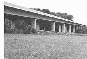
A1 Viadukt Löwenberg
