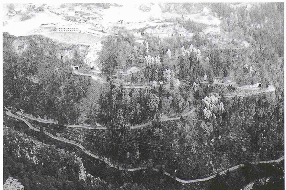
Luftbild der südlichen Talflanke des Maderanertals mit dem untersuchten Abschnitt der Bristenstrasse zwischen Amsteg (rechts) und St. Antoni (oben links)
