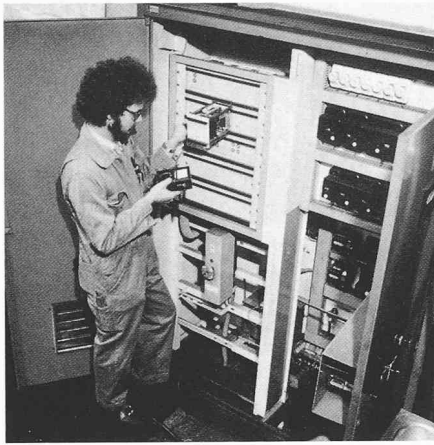
Bild 13. Elektroniker prüft Einschub-einheit
