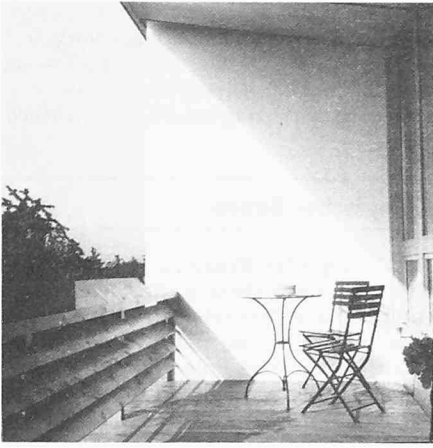
Balkonbrüstung. Das Sonnenlicht scheint durch und wird auf dem Lärchenboden zum Fenster reflektiert
