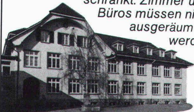
Schulhaus in Bremgarten, BE. Altbau renoviert mit Holz-Wechselrahmen-Fenstern und Isolierverglasung.
