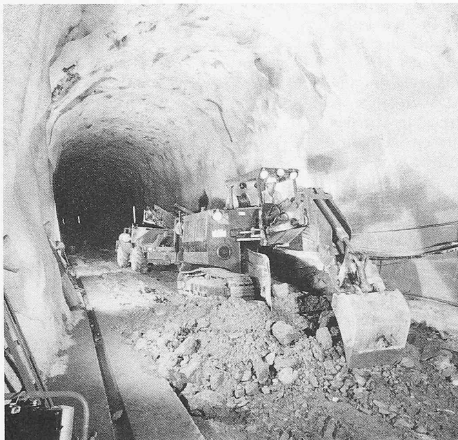
Bild 17. Sohlenreinigung bei Tm 6600
