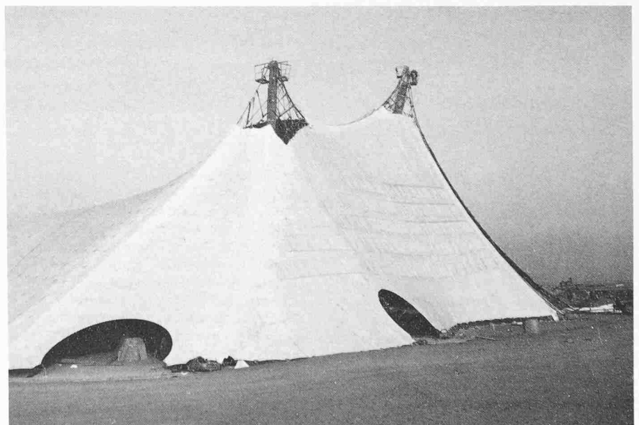
Teilansicht der fertig montierten Aussenmembrane
