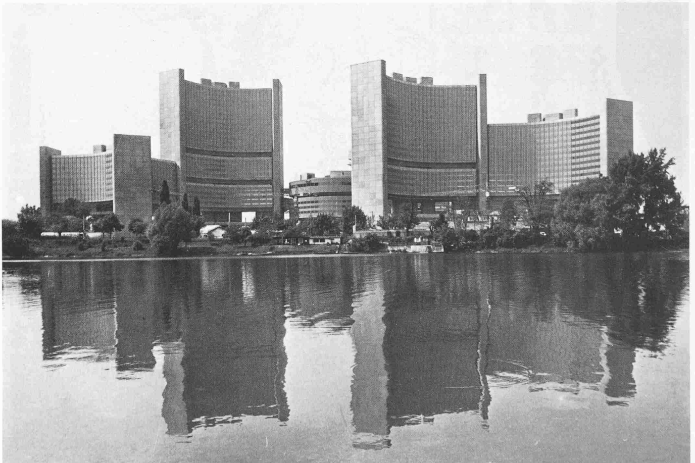
Blick von Südosten. In der Mitte halb verdeckt das Internationale Konferenzgebäude, rechts und links die Amtssitzgebäude für Internationale Organisationen
