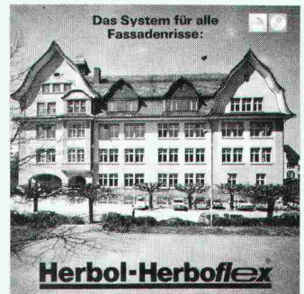
Das Neustadt-Schulhaus in Zug wurde 1976 ganzflächig mit dem HERBOL-HERBOFLEX Armierungssystem saniert. Ausführende Firma: Rolf Wesemann, Malergeschäft, Zug.
