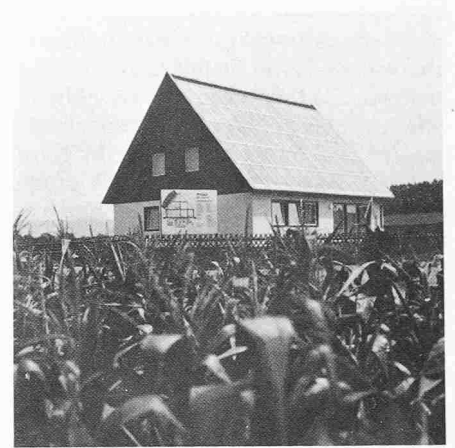
BBC-Solarhaus in Walldorf bei Heidelberg
