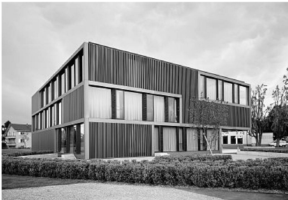
bâtiment scolaire revêtu de lamelles métalliques
