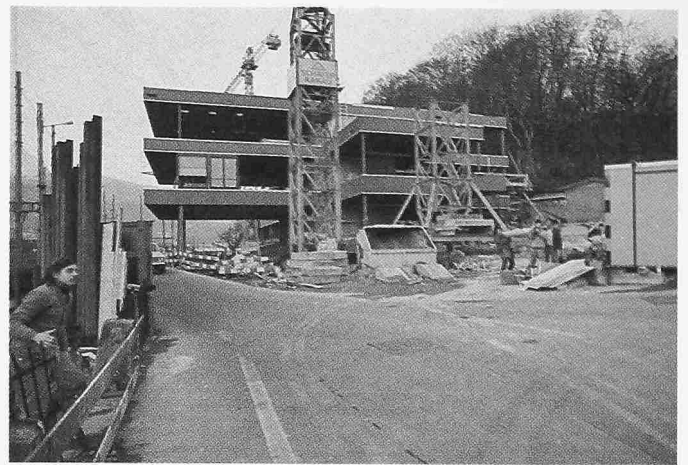
Montage der Dach- und Deckenränder
