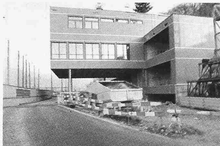
Montage der Fassadenelemente
