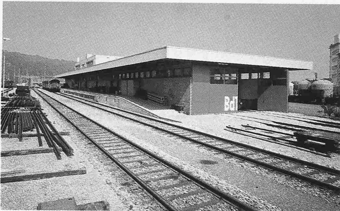
Bild 1. Olten: das neue Bahndienstzentrum mit Verladerampe
