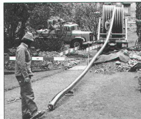
10.04 Die Verlegung der FLEXWELL-Leitung beginnt...
