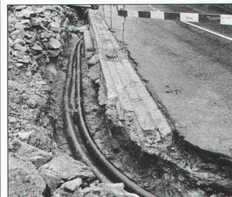
11.55 Komplett verlegt – 360 m nahtlose Fernwärmeleitung – Ziel erreicht!
