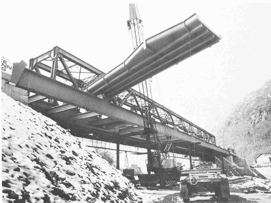
Bild 4. Montage der Stalkonstruktion (alle Photos: Photodienst der BLS-Werkstätte Böningen)
