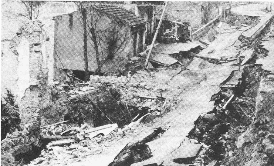
Bild 2. Strassenschäden in Calitri
