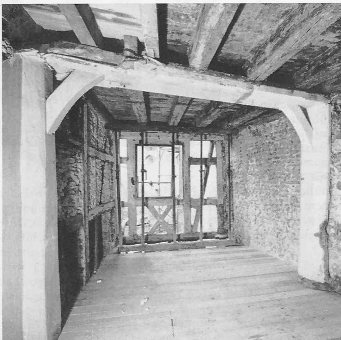
Freigelegte Tragkonstruktion im Haus Rheingasse 67
