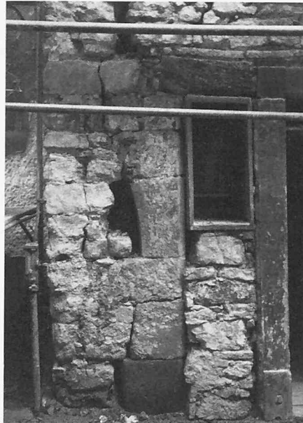
Sanierung des Eckverbandes, Detailansicht
