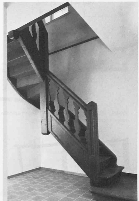
Im Haus Pfeffergässlein 10 erhaltene Treppe
