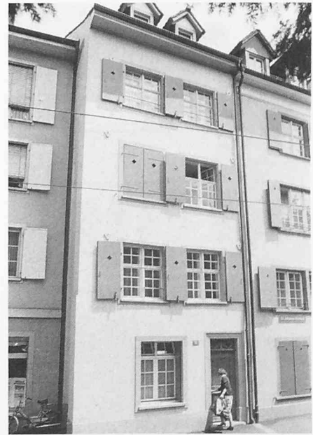
Strassenseite nach der Sanierung
