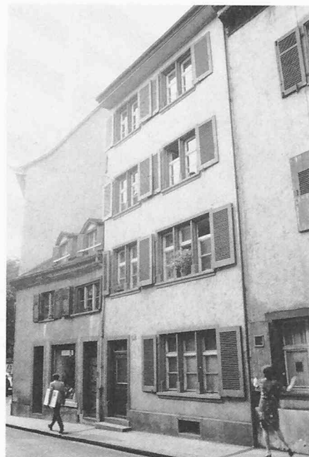
Rheingasse 65+67, Strassenfassade, vor der Sanierung
