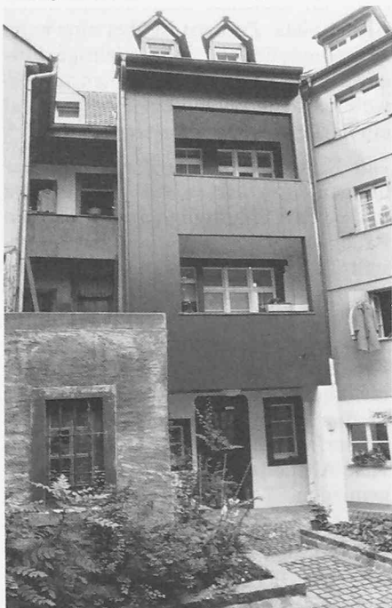
Rheingasse 69, nach der Sanierung
