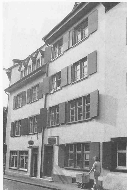
nach der Sanierung mit Neubau von Nr. 65
