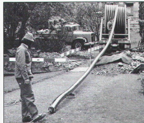
10.04 Die Verlegung der FLEXWELL-Leitung beginnt...
