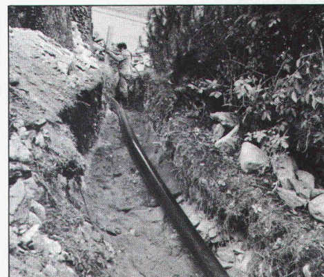
10.45 Die erste Länge ist verlegt...
