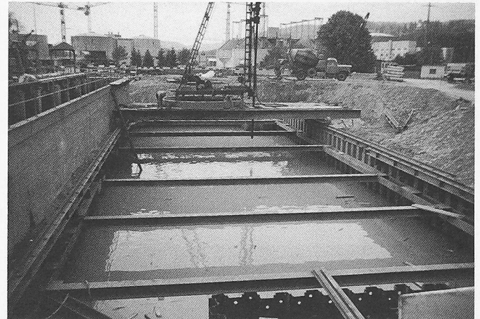
Bild 3. In bestimmten Arbeitsetappen werden Bauteile geflutet
