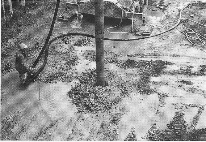
Bild 6. Rüttelverdichtung
